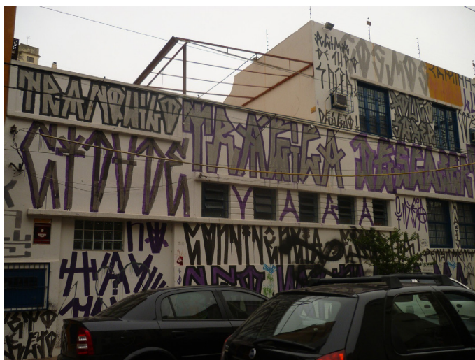
Figura. Pichações em edifício de Porto Alegre
